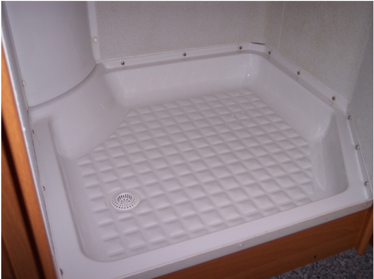
Douchebak gemonteerd, afvoer aangesloten en getest op lekkage.
