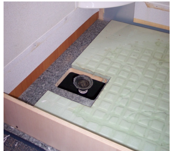
Opening voor afvoer te groot.
