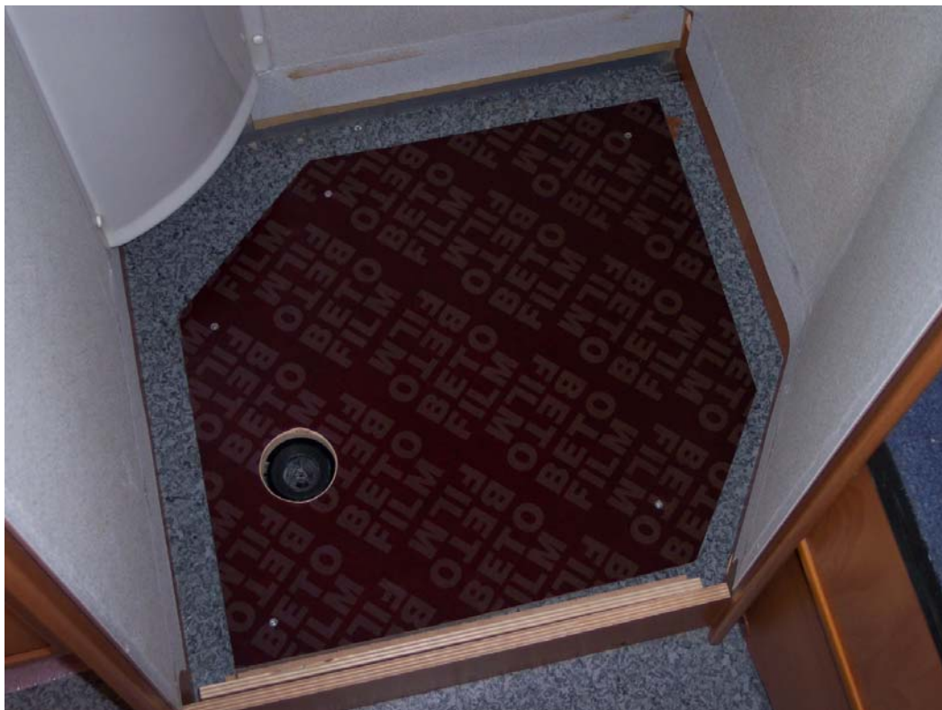
Multiplex op juiste plaats met schroeven gefixeerd op de bodem.
