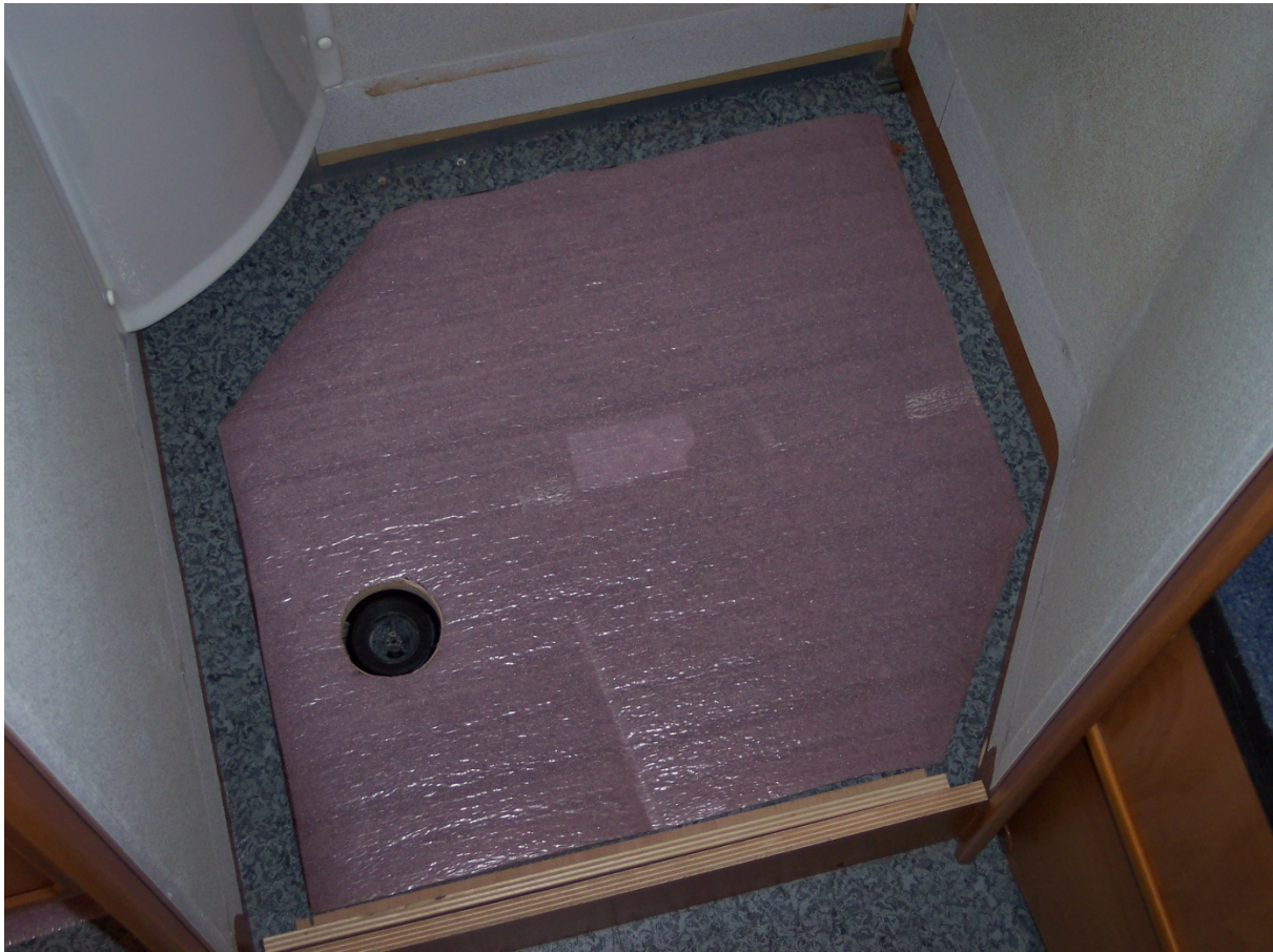
Laminaatondertapijt op maat geknipt en gefixeerd met plakband.
