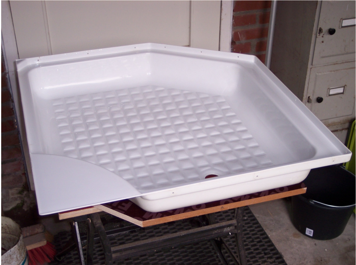
Gerepareerde douchebak gereed voor inbouw.
